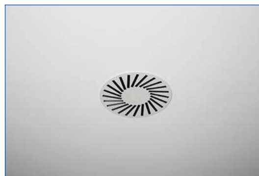
Монтаж в сплошные подвесные потолки
