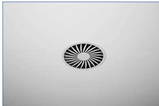
Монтаж в сплошные подвесные потолки
