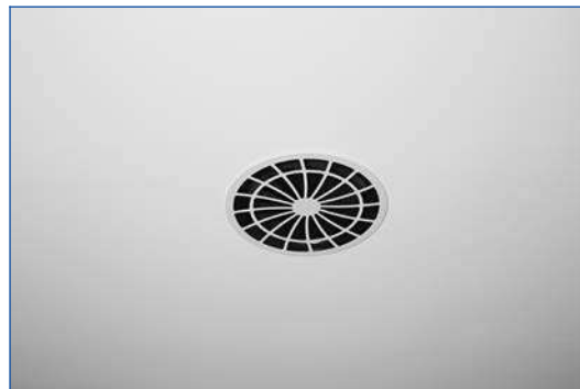
Монтаж в сплошные подвесные потолки
