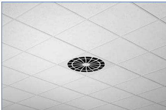
Монтаж в потолки с Т-образными профилями
