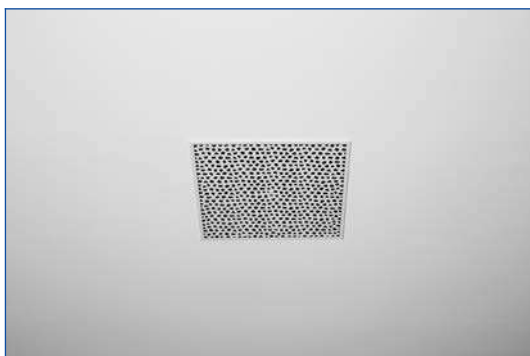
Монтаж в сплошные подвесные потолки
