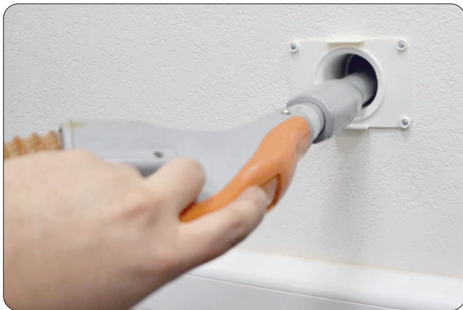
Рис. 8. Очистка воздухопроводящего канала бытовым пылесосом
