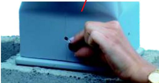
Установка гравитационного дефлектора Schiedel/Bryza на пустотелом вентиляционном блоке Schiedel
